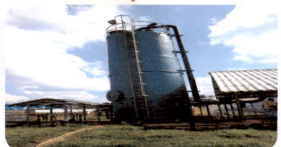
แก๊สที่ได้จะส่งเข้าถังลดซัดเฟออร์
